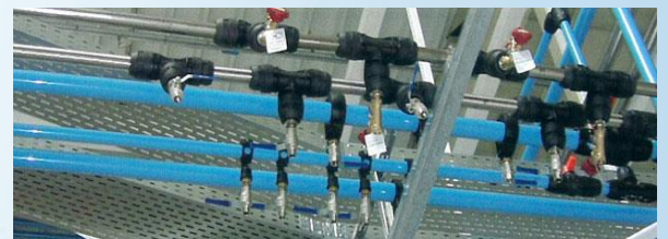
Installation réseaux d'air comprimé
